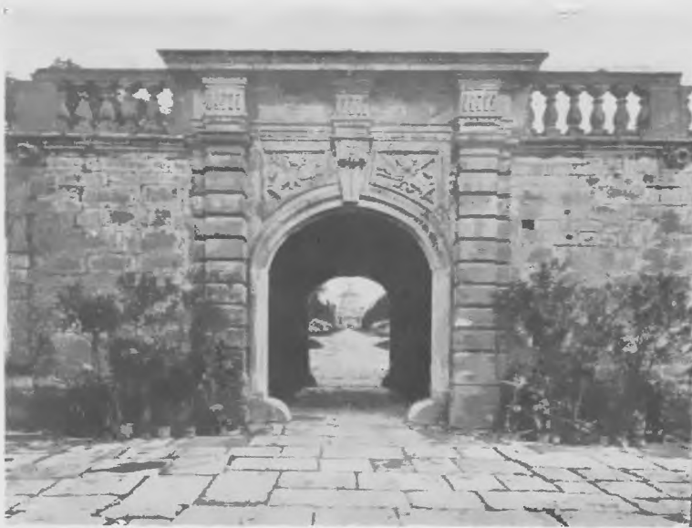
ZAMEK W PODHORCACH. Brama wjazdowa od strony podwórca.
