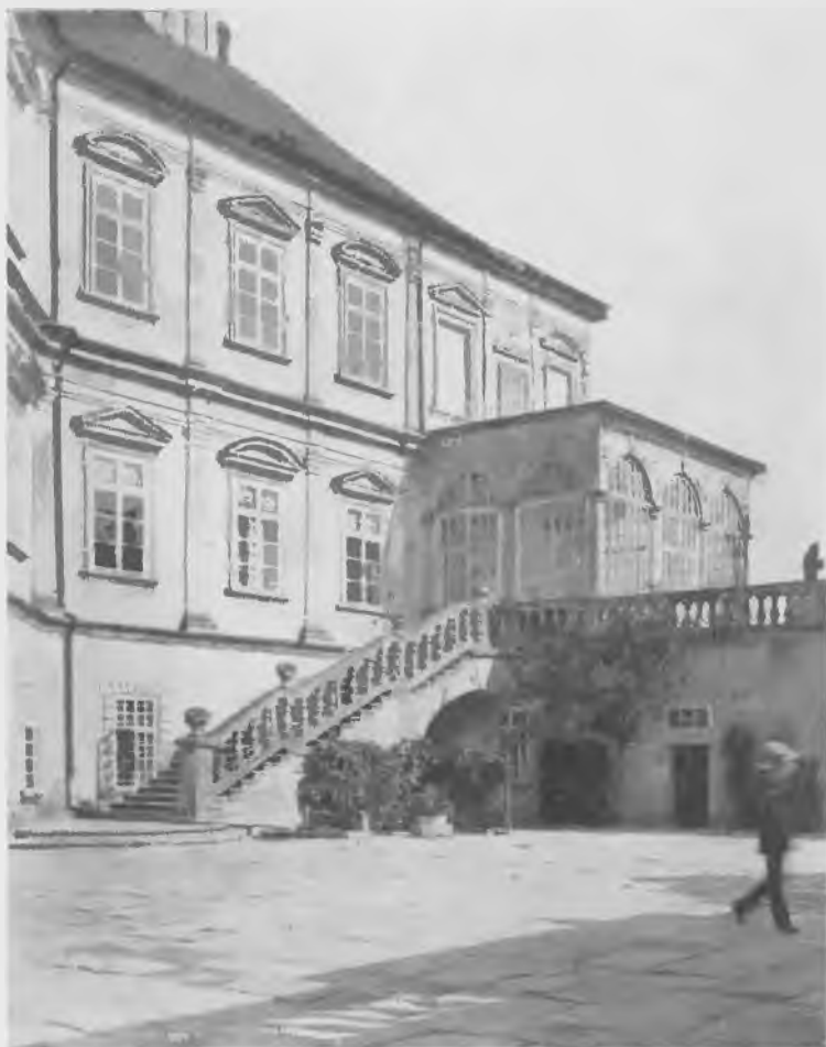
ZAMEK W PODHORCACH Widok od podworca.
