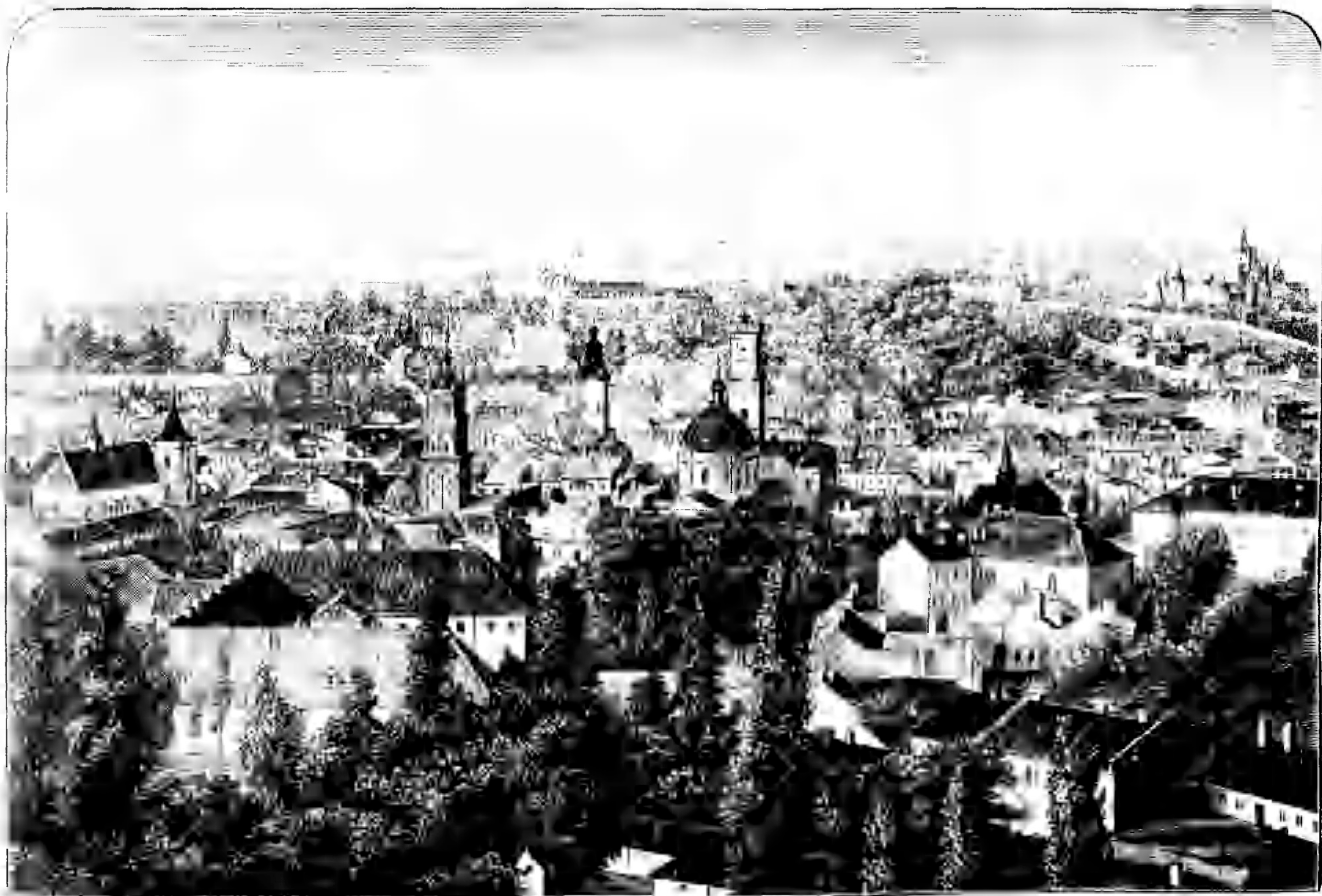
Widok ogólny Lwowa, zdjęty z Wysokiego zamku.
