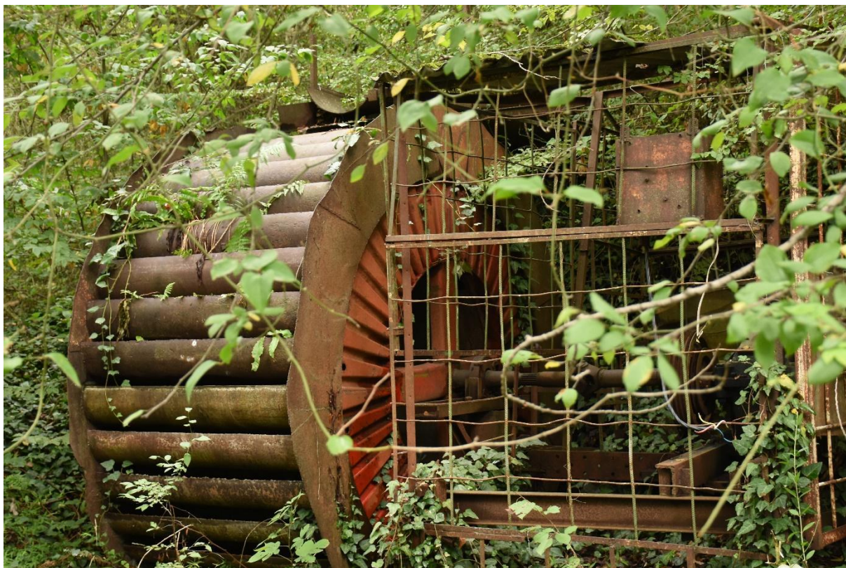
Nieczynna turbina wodna zasilająca w prąd okoliczne ulice w latach 90-tych XX wieku.
