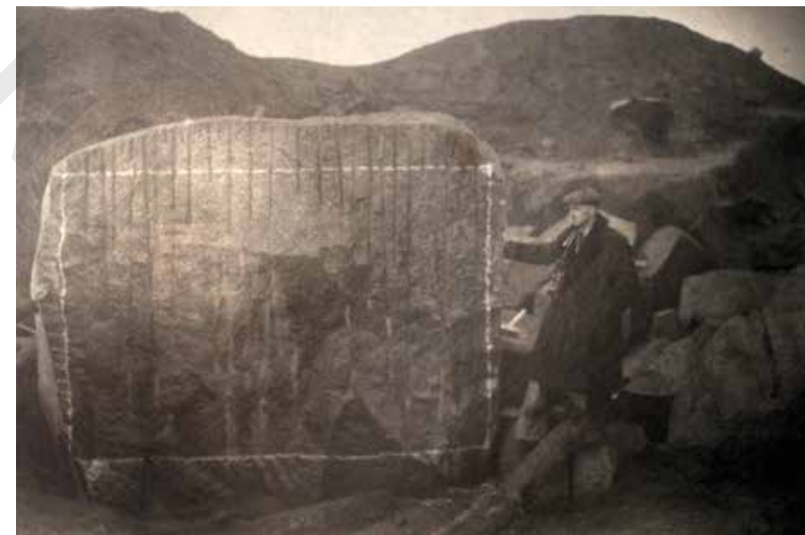
81 Granitowy blok na płytę do mauzoleum Piłsudskiego bezpośrednio po wydobyciu. Fot. LCVA, f. 51, ap. 2a, b. 750 (Likwidacyjne sprawozdanie materiałowe)
