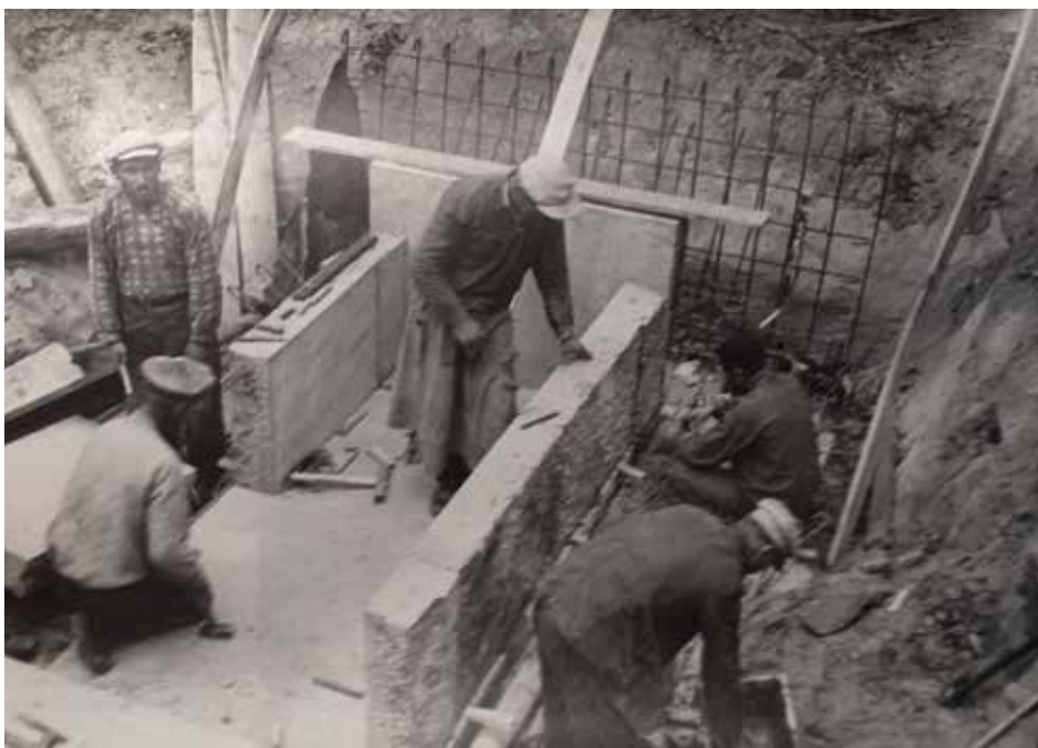
53 Prace przy budowie grobowca na serce Marszałka Piłsudskiego. Fot. LCVA, f. 51, ap. 2a, b. 750 (Likwidacyjne sprawozdanie materiałowe)
