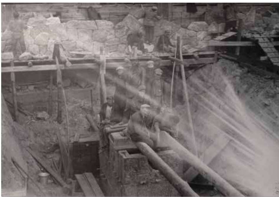
54 Prace przy budowie grobowca na serce Marszałka Piłsudskiego. Fot. LCVA, f. 51, ap. 2a, b. 750 (Likwidacyjne sprawozdanie materiałowe)
