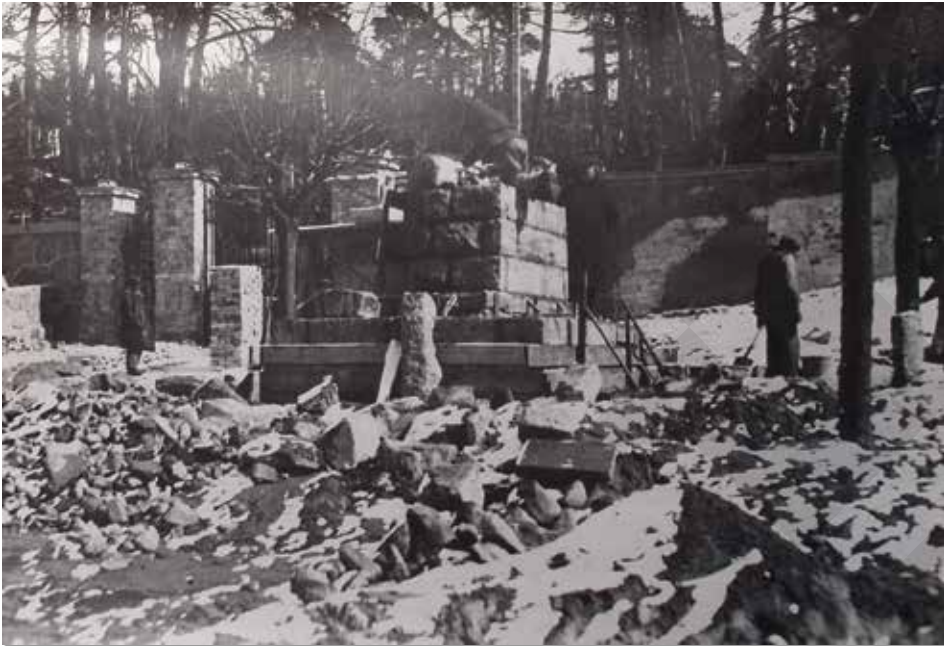
60 Budowa postumentu pod pomnik Dyneburzan w 1935 r. Fot. LCVA, f. 51, ap. 2a, b. 750 (Likwidacyjne sprawozdanie materiałowe)
