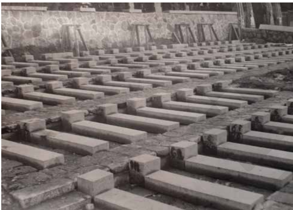
62 Prace kamieniarskie w Wilnie przy cokołach na groby żołnierzy. Fot. Fot. LCVA, f. 51, ap. 2a, b. 750 (Likwidacyjne sprawozdanie materiałowe)
