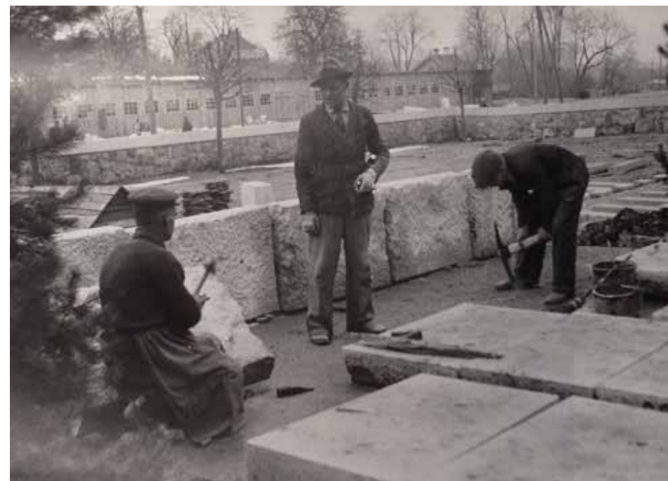
55 Prace przy budowie grobowca na serce Marszałka Piłsudskiego. Fot. LCVA, f. 51, ap. 2a, b. 750 (Likwidacyjne sprawozdanie materiałowe)
