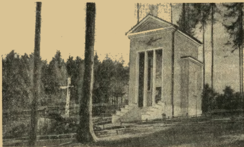
„Kaplica Żwirki i Wigury” w Cierlicku Górnym.
