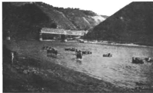
Ryc. 180. MOST ŁĄCZĄCY ZALESZCZYKI Z RUMUNJĄ.
